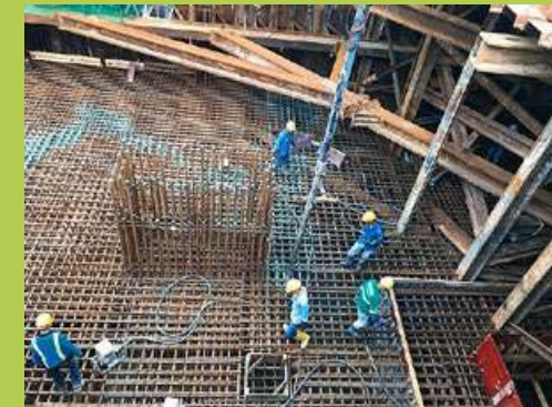
Busy project site 工人正為工程趕工
