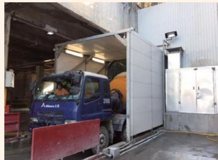
混凝土車裝載處以 100 毫米厚的 G.I. 聲學面板圍封，不僅減少了噪音對環境的影響，廠房的工作人員也受益於下降了的噪音水平。
