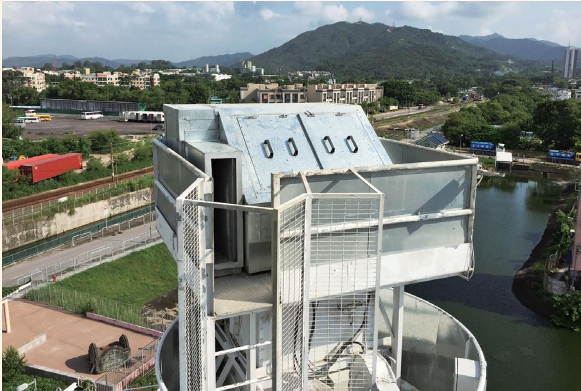
在集塵裝置上安裝具有高隔音性能的 G.I. 面板的消音裝置，減少了對周邊地區的噪音污染。
