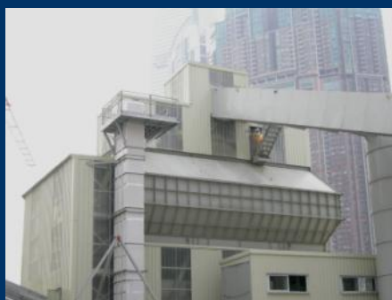
密封設計的生產線和石料運載船控制了污染物傳播往四周的環境，亦可以把機械運作的噪音在源頭予以隔離
