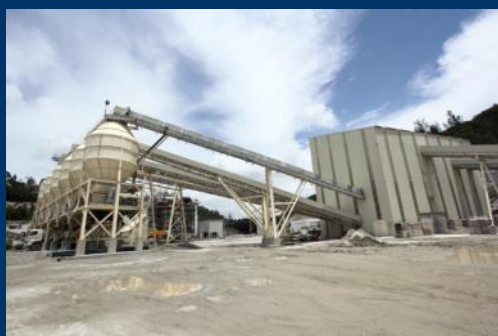
密封設計的生產線和石料運載船控制了污染物傳播往四周的環境，亦可以把機械運作的噪音在源頭予以隔離
