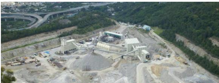
藍地石礦場的石排設計，可作為天然屏障壓抑噪音和塵埃擴散到四周範圍
