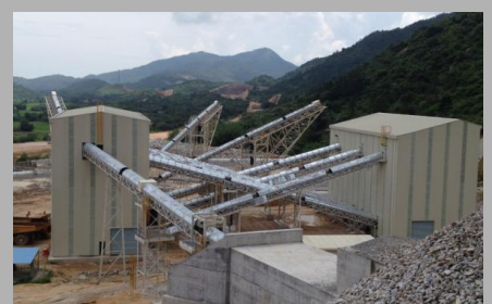
惠東石礦場密封設計的破碎機組把噪音從源頭隔離
